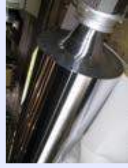
ロール面 HCrメッキ補修
