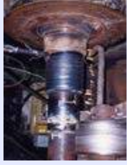
Brg取付部摩耗への補修
