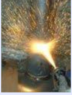
Brg取付部摩耗への補修
