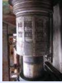
ジャーナル補修前
