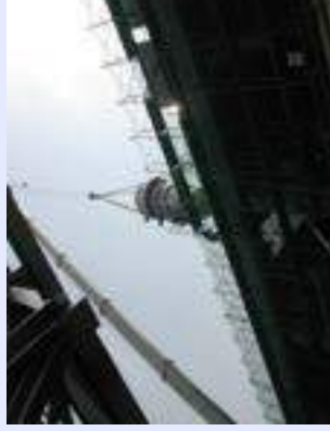
抄紙(原質設備)据付工事
