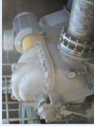
遠心渦巻きポンプ(両吸込みタイプ)
