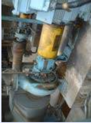
遠心渦巻きポンプ(片吸込みタイプ)
