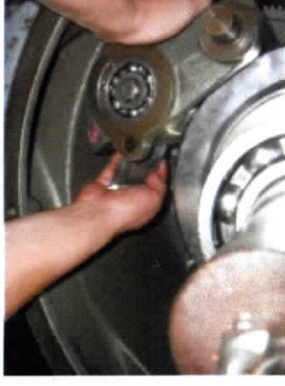
バイエル変速機(内部)
