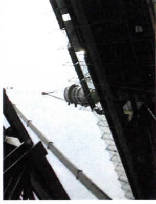
抄紙(原質設備)据付工事
