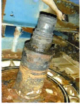
ジャーナル補修前
