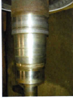
Brg取付部 摩耗
